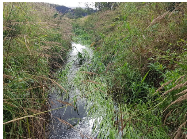
Figur 6. Oversiktsbilde fra Foruskanalen Vest. Foto: Inga Greipsland.
